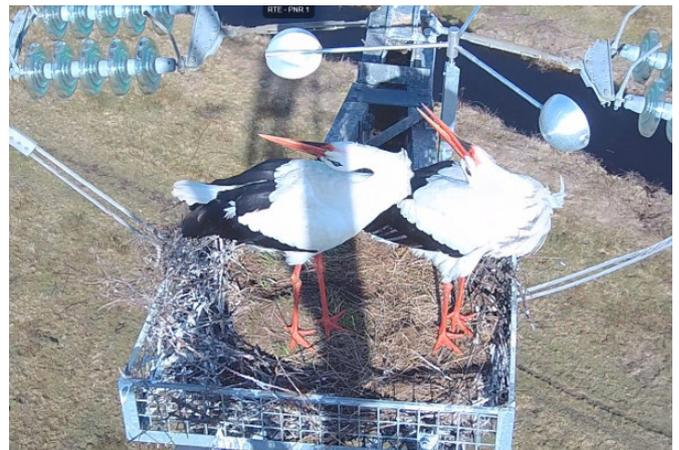
Les nids sont sécurisés par un panier destiné à éviter le basculement. A l'arrière, on aperçoit l'anémomètre installé par RTE pour éviter que les cigognes construisent leur nid juste au-dessus des lignes.
