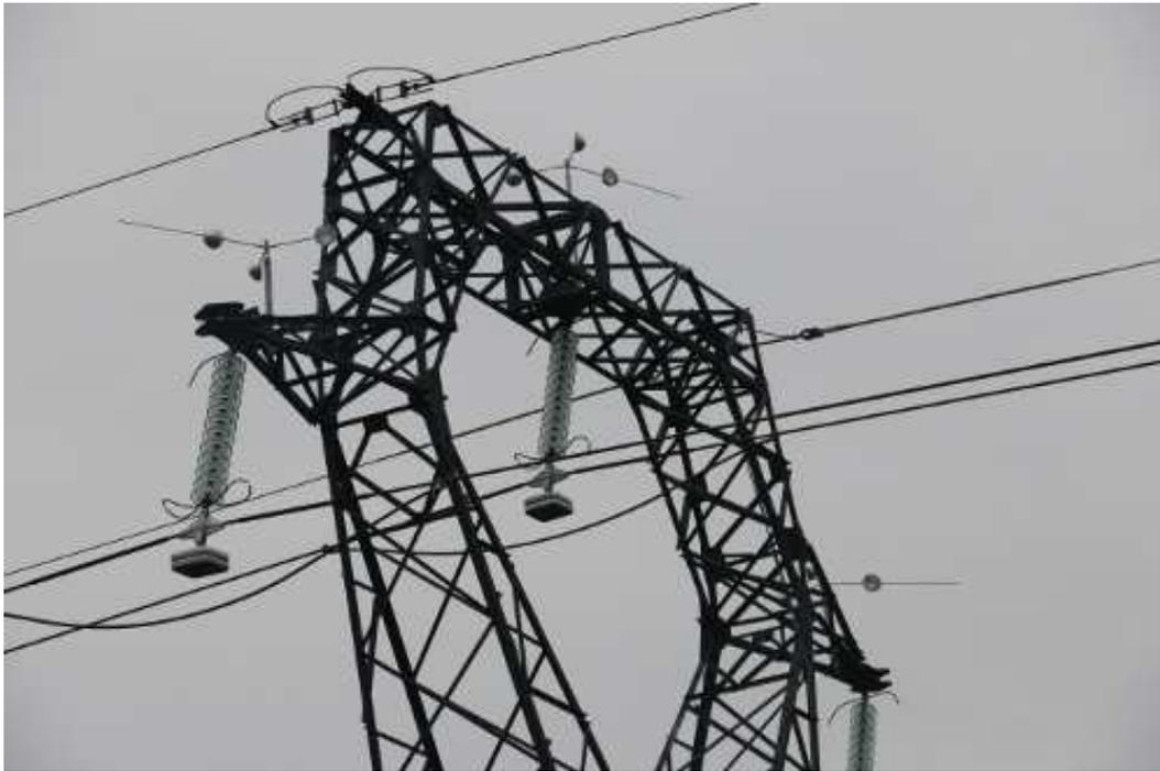
Deux lignes traversant le marais Audubon à Saint-Etienne-de-Montluc et Couëron viennent d'être équipées d'anémomètres par R.T.E. L'objectif est d'éviter que les cigognes construisent leur nid juste au-dessus des lignes. Un panier a été installé sur les pylônes où un nid était déjà construit. Cet investissement important devrait contribuer à éviter les électrocutions et les incidents sur la ligne.
