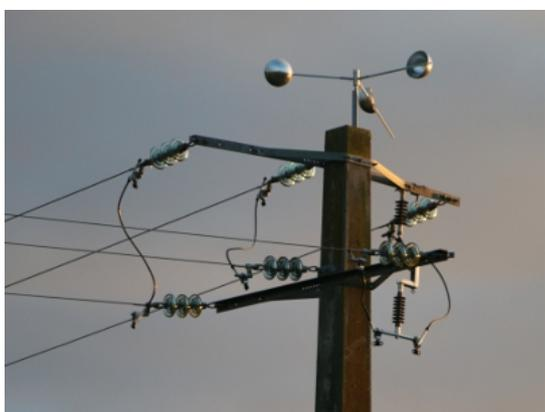
Près de ce dortoir sur les arbres passe une ligne de 20.000 volts. Une cigogne s'y est électrocutée l'an dernier et à notre demande ERDF l'a sécurisée en posant des anémomètres sur plusieurs poteaux pour empêcher les cigognes de se poser.
